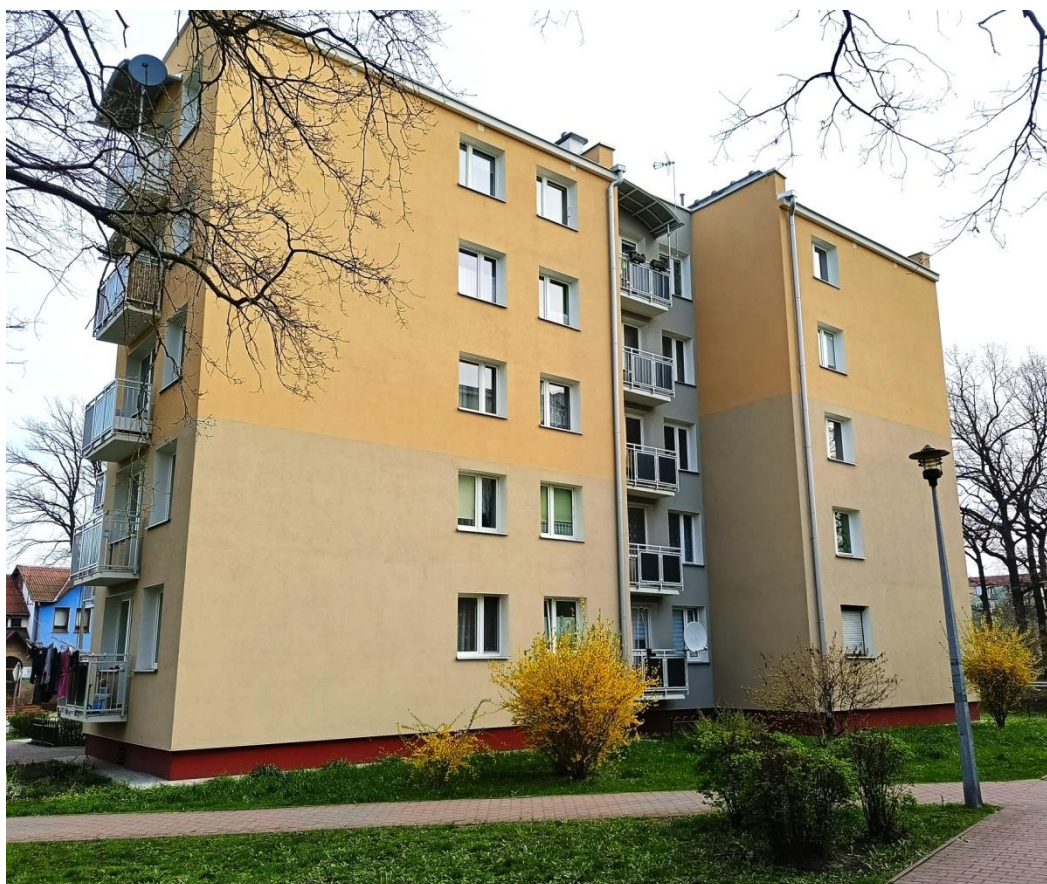
Foto: elewacja południowa
